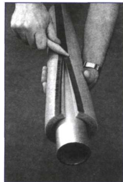
Рис. IV.67. Изоляция с замком-защелкой
