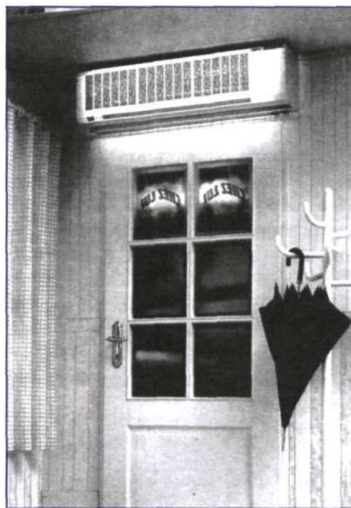
Рис. IV.19. Воздушно-тепловая завеса Thermozone AC200 фирмы FRICO
